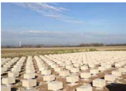
Paaldeksels werk Windpark Zuidwester Urk Voorbij Funderingstechniek.
