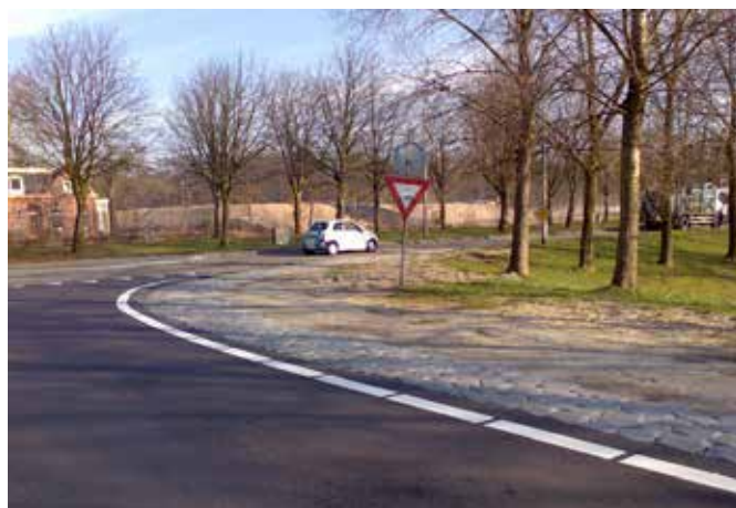
Betonnen Kantzuilen als rammelstrook.
