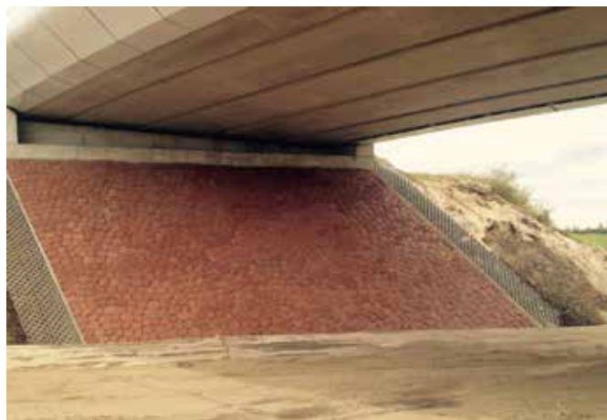
Kantzuilen bij viaduct A1 - A6.
