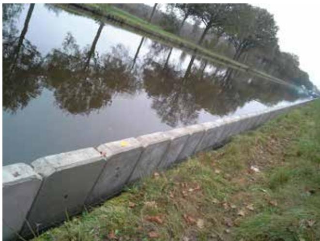
Damwandplank visbekaansluiting 'direct-ontkist'.
